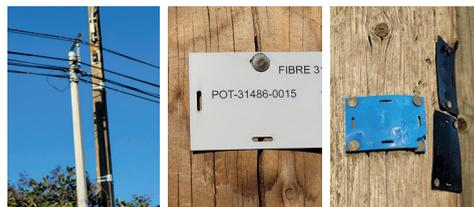
**A savoir :** Le câble optique est visible et posé sur des supports métalliques au-dessus du réseau cuivre. Les poteaux Fibre 31, quant à eux, ont une étiquette blanche et les poteaux de l'opérateur historique une étiquette bleue.
